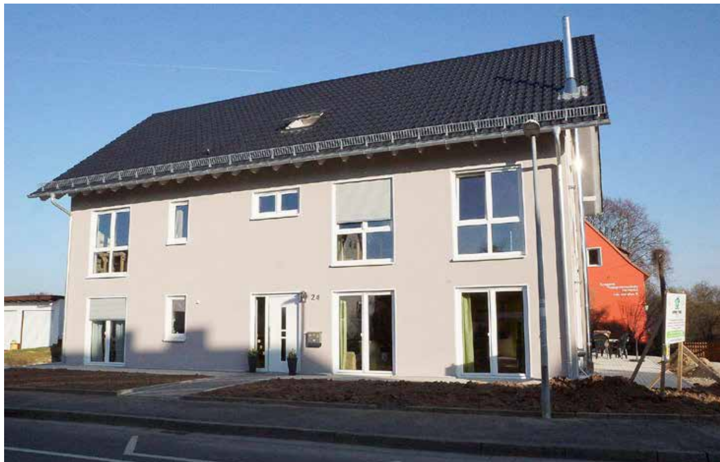
Zeitplan eingehalten: Das dreigeschossige Haus war gut sechs Monate nach Baubeginn bezugsfertig.
