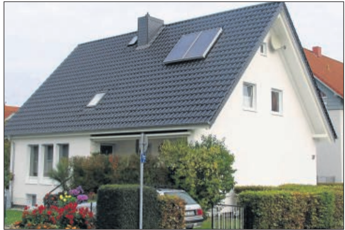
Vorher und Nachher: Bei dieser Dachsanierung wurde von Sander Haus nicht nur der Dachüberstand vergrößert, das Haus bekam eine Aufdachdämmung und eine neue, hinterlüftete Fassade. Außerdem wurde eine Solaranlage auf dem Dach installiert. Fotos: Sander Haus/Repros: Hoffmann
